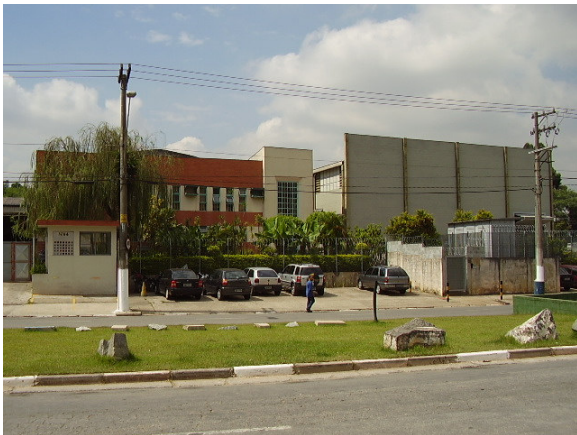
Figura 3 - Fachada da Empresa
